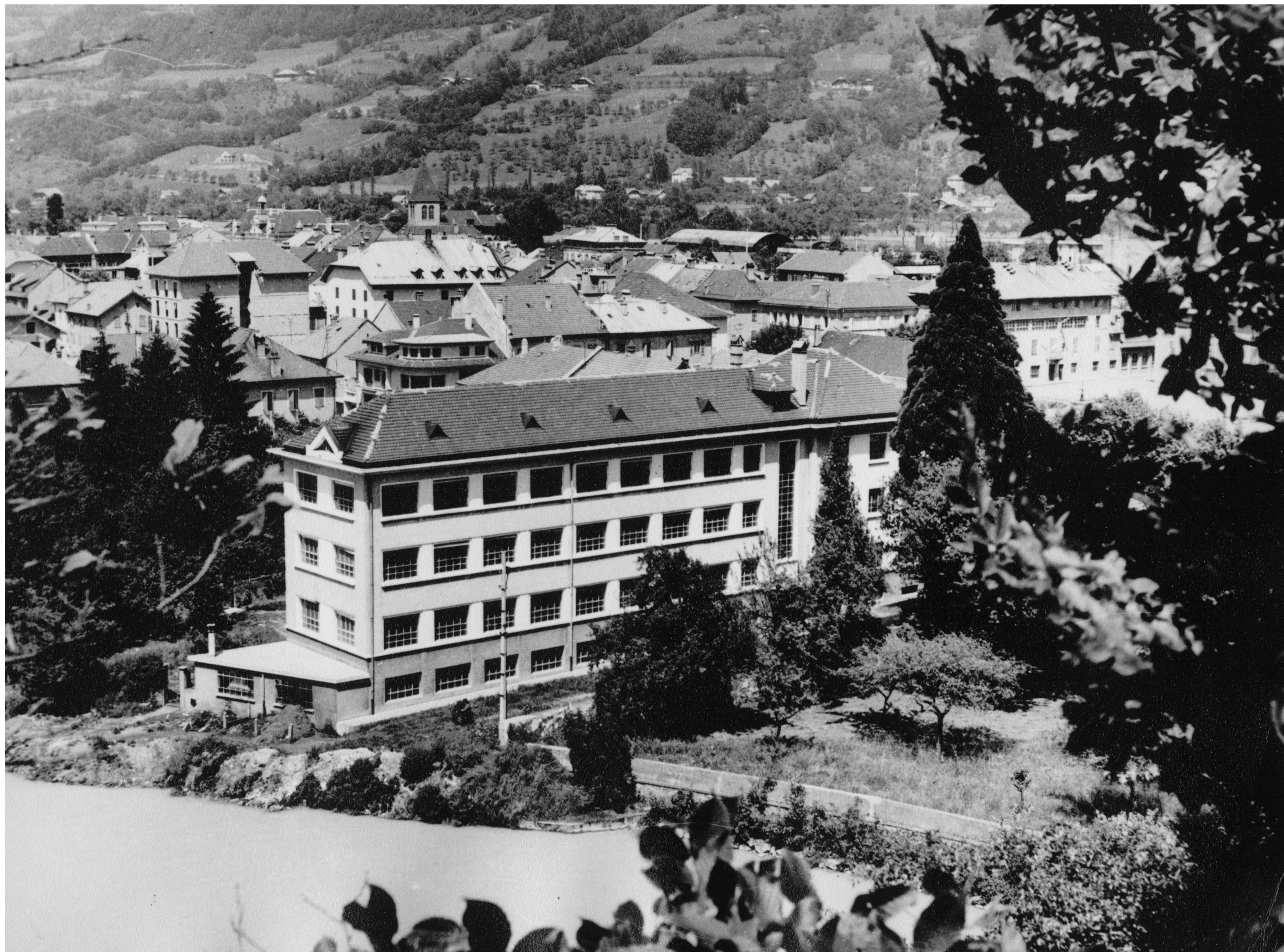
l'usine Bretton, en bord d'Arve : un bâtiment érigé en 1933
